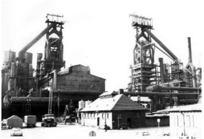
Figure 20: Les Hauts-fourneaux A et B, Esch-Belval
