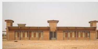
Cheminiées solaires, Coopération luxembourgeoise au Niger, 2016 Source: LuxDev (2016), construction bioclimatique au Niger
