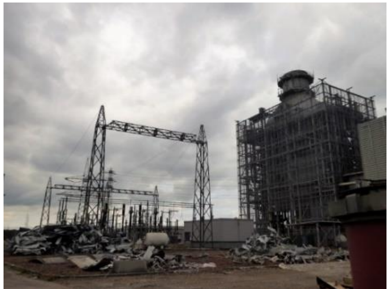
Figure 21: Démantèlement de la centrale turbine gaz-vapeur à Esch-sur-Alzette, 2017 79
