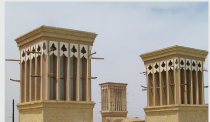
Refroidissement bioclimatique, baghirs, Iran
