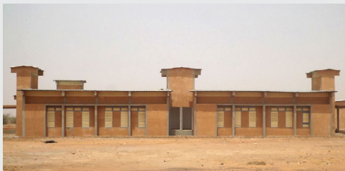
Cheminées solaires, Coopération luxembourgeoise au Niger
